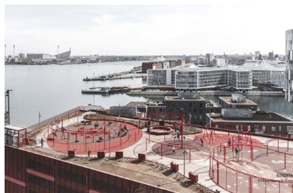
P-hus og Konditaget Lüdgers i Nordhavn er designet af JAJA Architects. 2016. © Rasmus Hjortshøj / Coast Studio.
